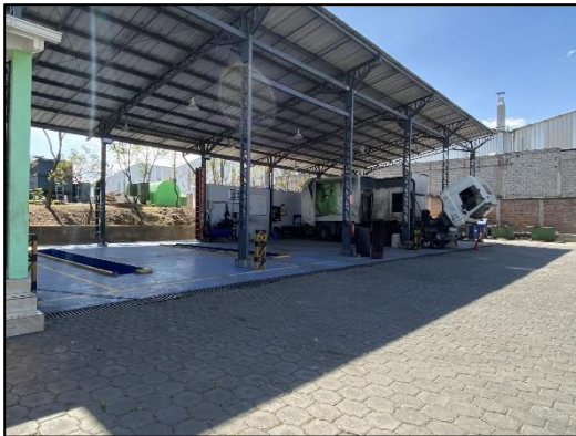
ÁREA DE MANTENIMIENTO BÁSICO DE VEHÍCULOS
